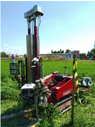
Foto8: particolare esecuzione Cpt 5
