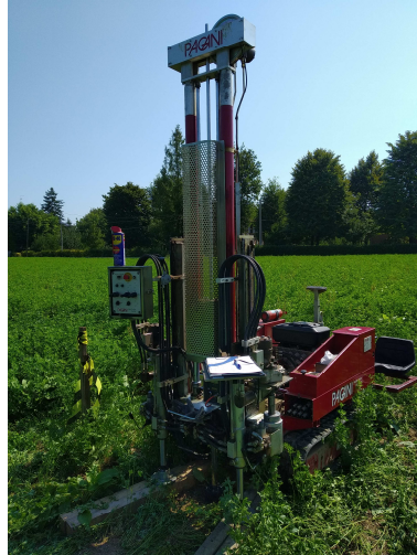
Foto9: particolare esecuzione Cpt 6
