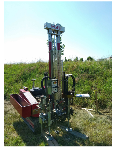
Foto7: particolare esecuzione Cpt 4
