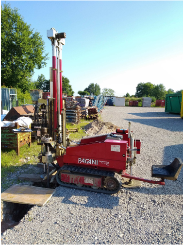
Foto5: particolare esecuzione Cpt 2
