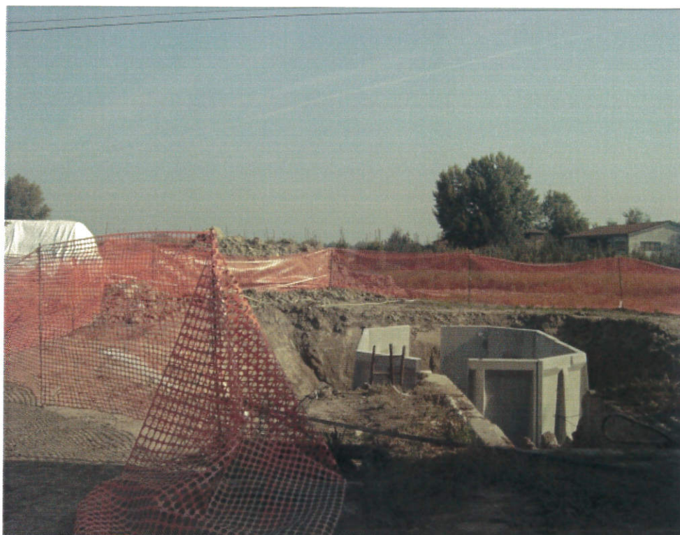
vasca ottagonale durante la sua esecuzione
