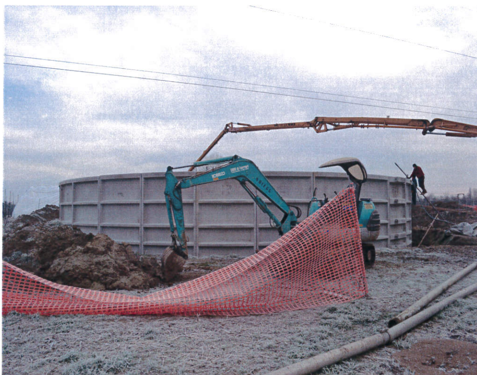
Vasca circolare durante l'esecuzione di alcune opere
