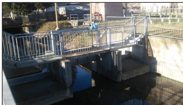
Figura 25: Manufatto irriguo sul Cavo Argine.
