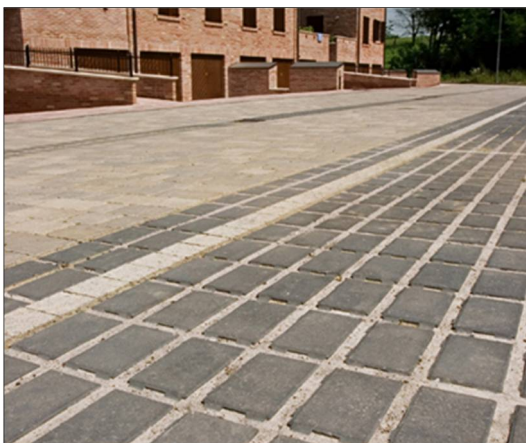
Figura 20: Una pavimentazione drenante (Fonte: Masulli).
