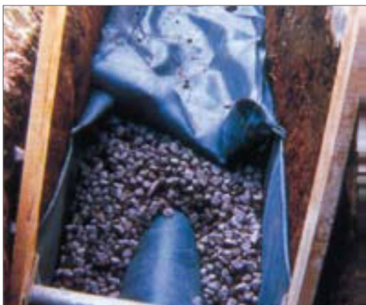
Figura 22: Una trincea d'infiltrazione (Fonte: EPA).
