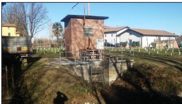
Figura 24: Impianto di sollevamento "Le Pioppe".
